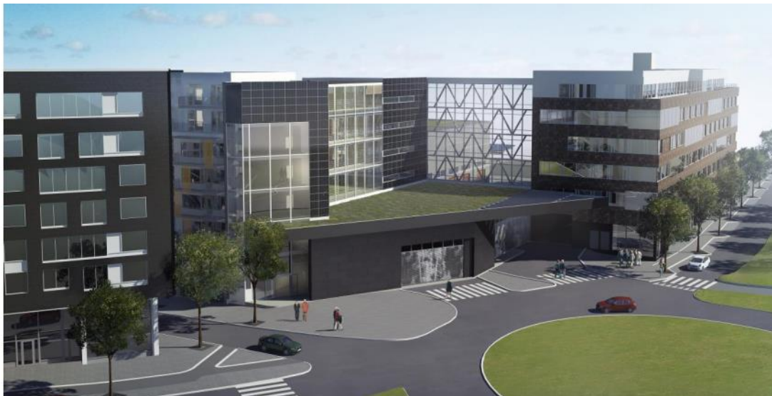
Figur 4-5: Totalt er bygningen på 50.000 kvadratmeter med bussparkering i 1. etasje, bilparkering og servicefunksjoner i 2. etasje (delvis under bakken), drivstoff, vask og verksted i 3. etasje, og kontorer i etasjene 4-7. Første spadetak ble tatt i 2012, og prosjektet forventes ferdig 2017. Kostnaden var ca 1,3 mrd SEK. Skanska.
